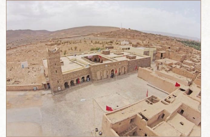
زاوية أسا ، المصدر: مديرية التراث الثقافي Zaouia Assa, source : DPC
